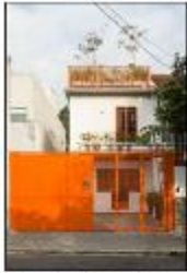
REFORMA RESIDÊNCIA - RUA CONDEPUS, MANDURÍ (Foto: Lindley Muller)
